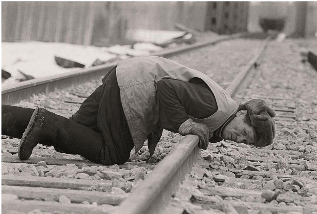
Bauarbeiter beim Streckenjustieren an der BAM beim Fluss Kitschera, Burjatien, März 1982
