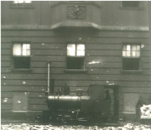
Dampflokomotive vor der Staatlichen Augusta-Schule in der Pallasstraße (Schöneberg), die eine Lorenbahn zwischen dem Winterfeldtplatz (Baustofflager) und der Bunker-Baustelle zog. Foto: Privatbesitz Horst Schütze
